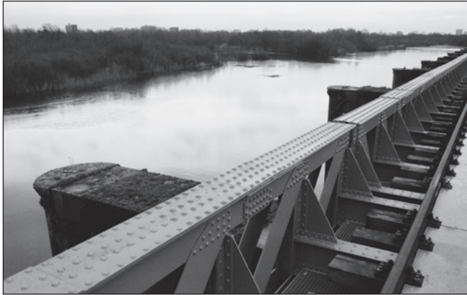
De gerestaureerde 'spoorbrug' over de Moerputten
